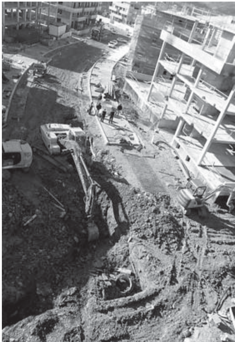
Obra en la que trabajaba el fallecido. [GORKA ESTRADA/EFE]
